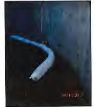
(c) Colocaron barreras absorbentes en la salida de la escorrentía adyacente al generador de emergencia.
