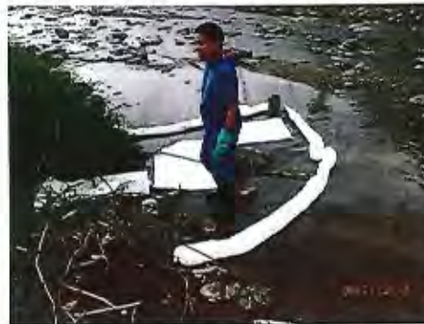
(b) Colocaron barreras y mantas absorbentes en el punto final del sistema de drenaje pluvial en el Río Cagüitas.
