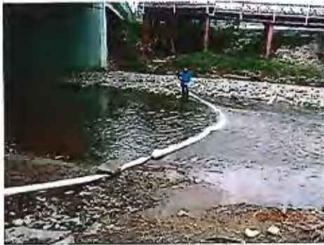
(a) Colocaron barreras absorbentes en el Río Cagüitas para evitar que el diésel continúe expandiéndose.
