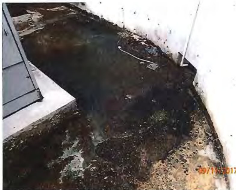
Figura 2. Salida de escorrentía adyacente al generador de emergencia en el que pasó el diésel derramado por el estacionamiento de la Nueva Casa Alcaldía.
