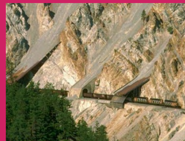
Túneles para proteger vías
