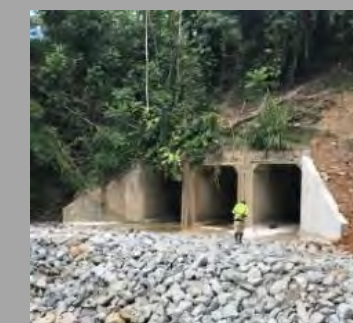
Puente box culvert. Foto de Desarrolladora JA (s. f.)
