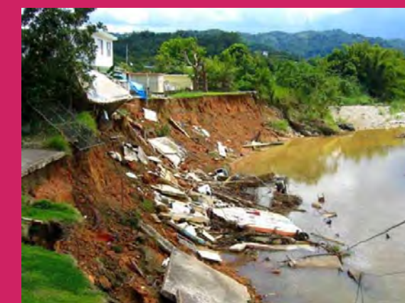
Erosión de meandro en el río Turabo
