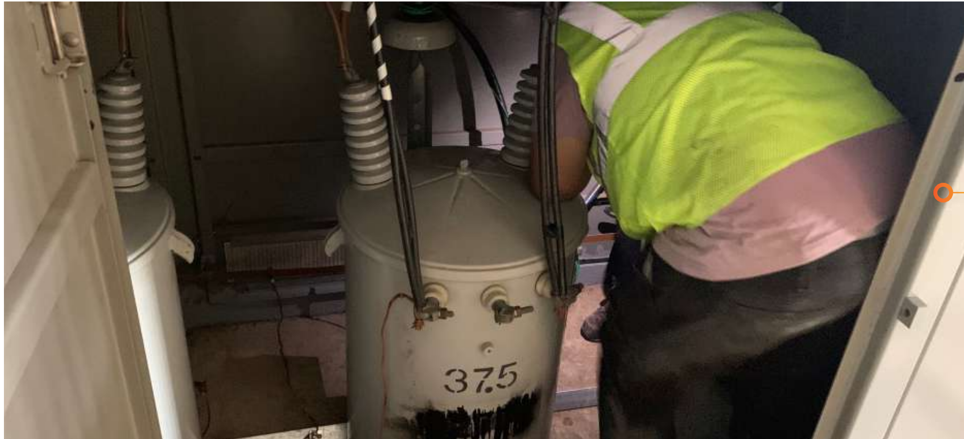
Personal de Trinity trabaja en el reemplazo de los transformadores dentro de las subestaciones.
