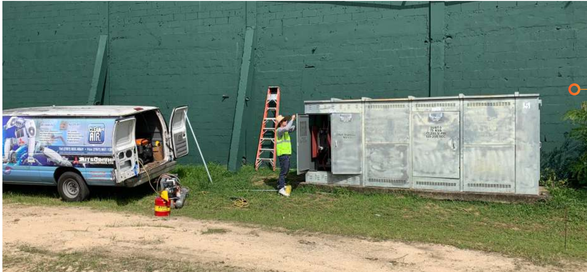
El alcance de los trabajos incluye la preparación de superficie y pintura de los gabinetes de las subestaciones.
