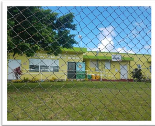
CHS Bunker Antes
