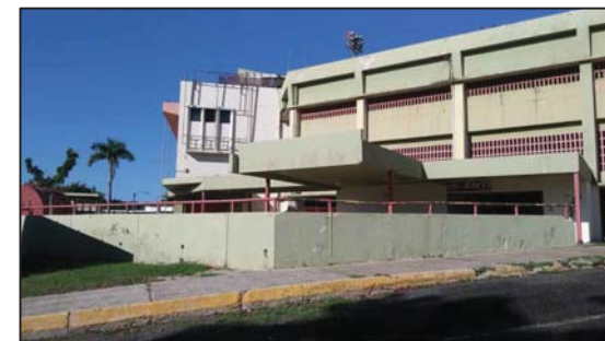
TECHO ENTRADA SECUNDARIA A SER IMPERMEABILIZADO
