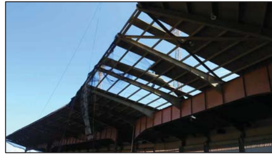
AREAS SIN CUBIERTA (PLANCHAS)
