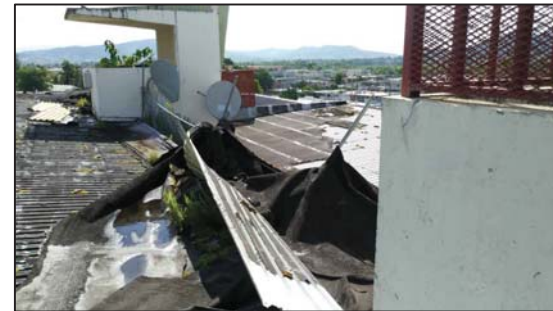
MATERIAL EXISTENTE A SER REMOVIDO Y VISTA DEL TECHO VIP
