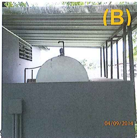
Figura 2 (A) Generador de Emergencia y (B) tanque de diesel de ~280 galones– Planta Tratamiento
