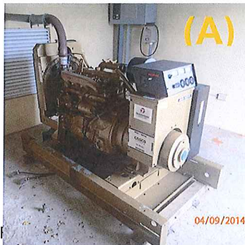
Figura 2 (A) Generador de Emergencia y (B) tanque de diesel de ~280 galones– Planta Tratamiento
