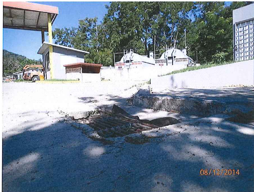
ALCANTARILLA PLUVIAL CERCANA A LA UBICACIÓN DE LOS TANQUES
