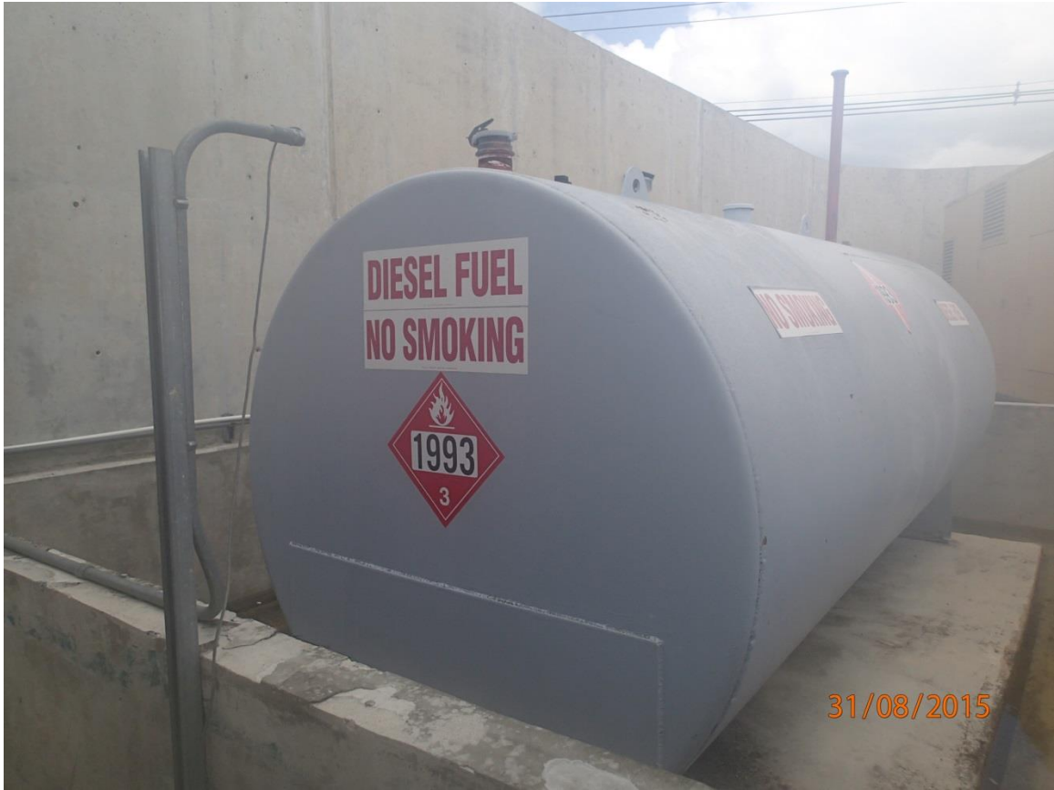
Figura 2 Tanques sobre terreno de diésel de 2 000 galones
