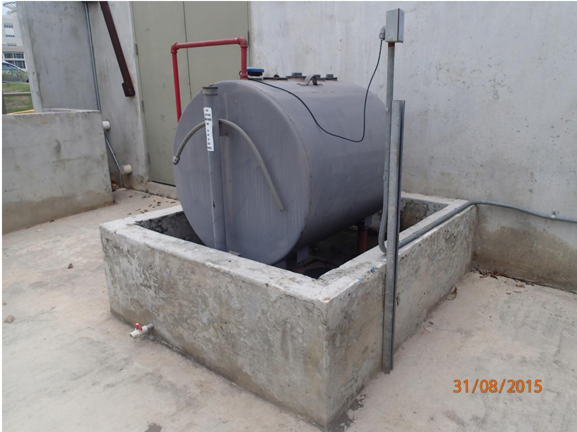
Figura 3 Tanque sobre terreno de 250 galones
