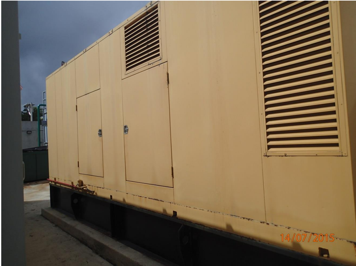
Figura 4: Generador de emergencias con tanque autocontenido de 500 galones.
