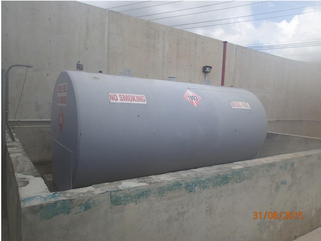
Figura 1 Tanques sobre terreno de diésel de 2 000 galones.
